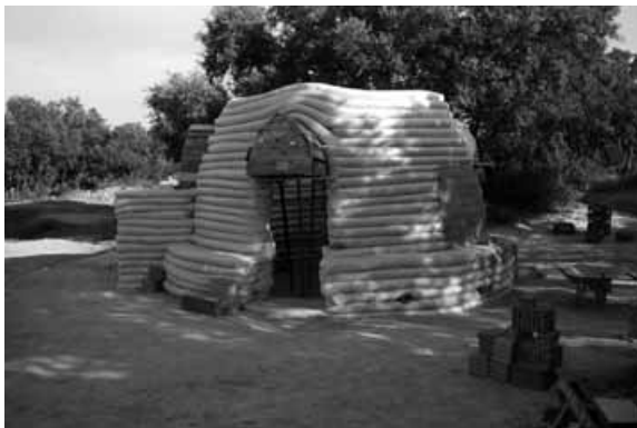
Estado del domo a mediados de agosto de 2014.
